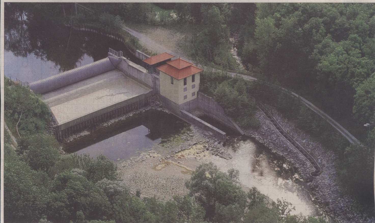
Was lange währte, wurde endlich gut: Das Wasserkraftwerk an der Wertach in Türkheim liefert seit zehn Jahren Strom.
